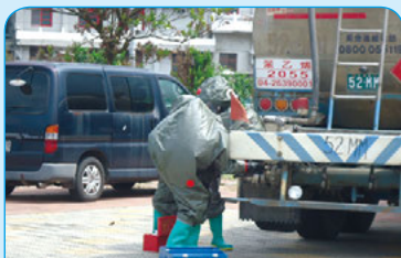
應變人員進行洩漏點修復作業
