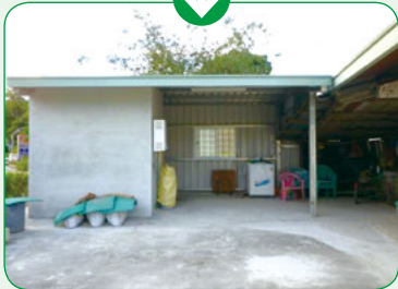
修繕後（新建衛浴間，鋪平走道）
