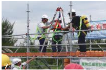
施工人員實際進行局限空間、用電等作業示範訓練
