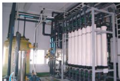
廢水回收設備 UF 及 RO 膜組
