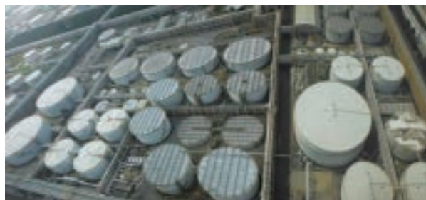
❏ 廢水處理場 (改善後)
