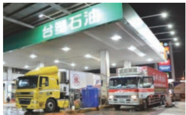
► 響應政府節能政策，推動安裝 LED 投射燈、天井燈等節能燈具，使站體整潔明亮
