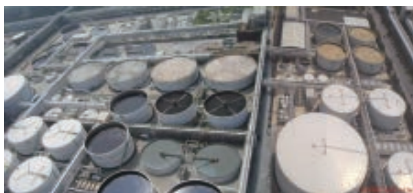
❏ 廢水處理場 (改善前)
