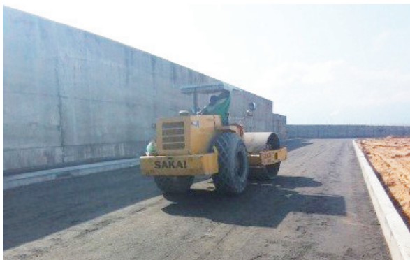
南三碼頭後線道路工程
