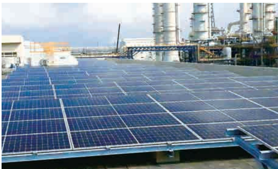
ARO2 控制室屋頂
