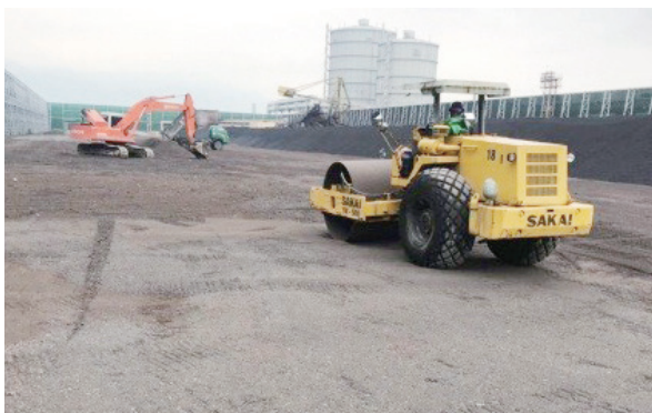
落地燒結堆場整地工程
