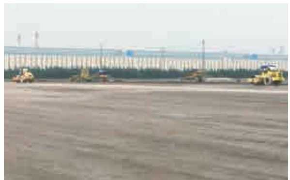
扁鋼胚外儲區整地工程
