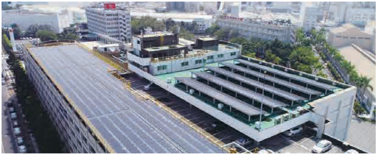
圖八 台塑仁武廠員工停車場及行政大樓頂樓設置太陽能板
