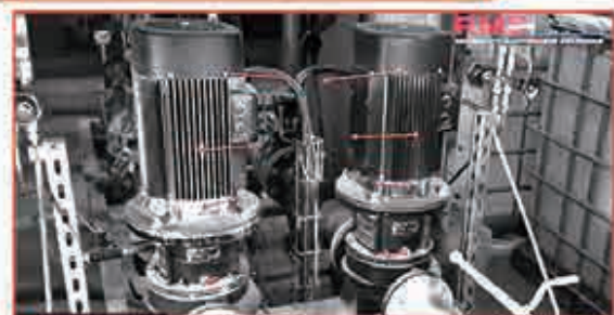
振動相對方向、破壞頻率(頻譜) 濾波作動、晃動軌跡觀察
