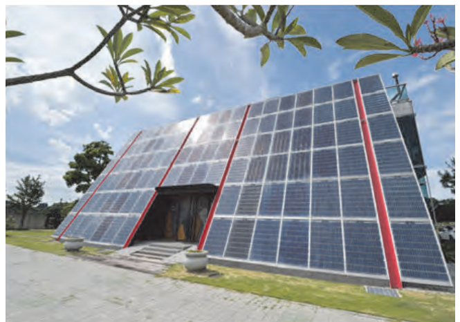
行政院頒佈之「建築整合型太陽光電發電」設備設置【頂蓋式】及【帷幕式】型式例示圖
