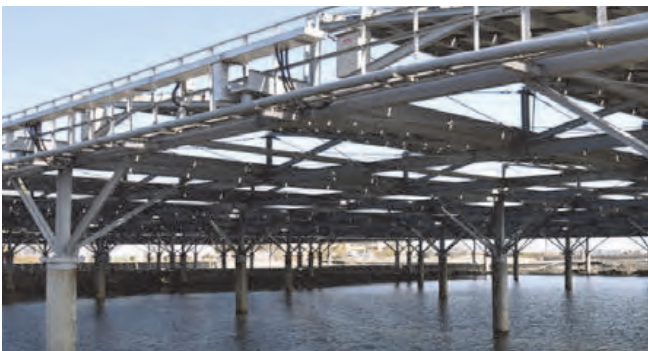
太陽能線槽設置於臨水地區示意圖
