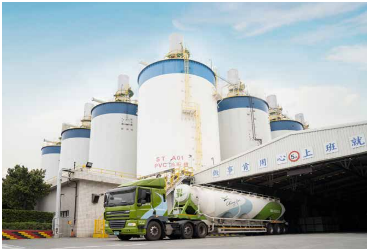
..... 麥寮廠區 PVC 廠
