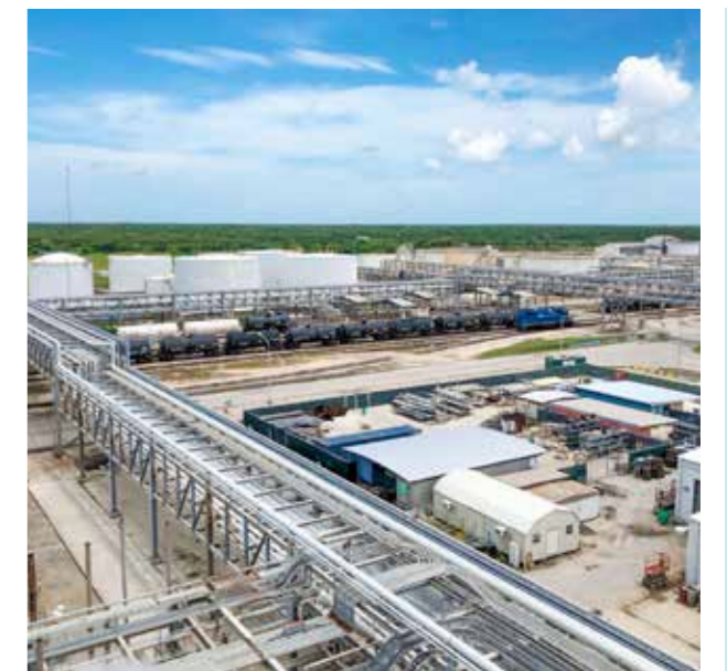
美國德州廠區乙二醇鐵路車裝載站
