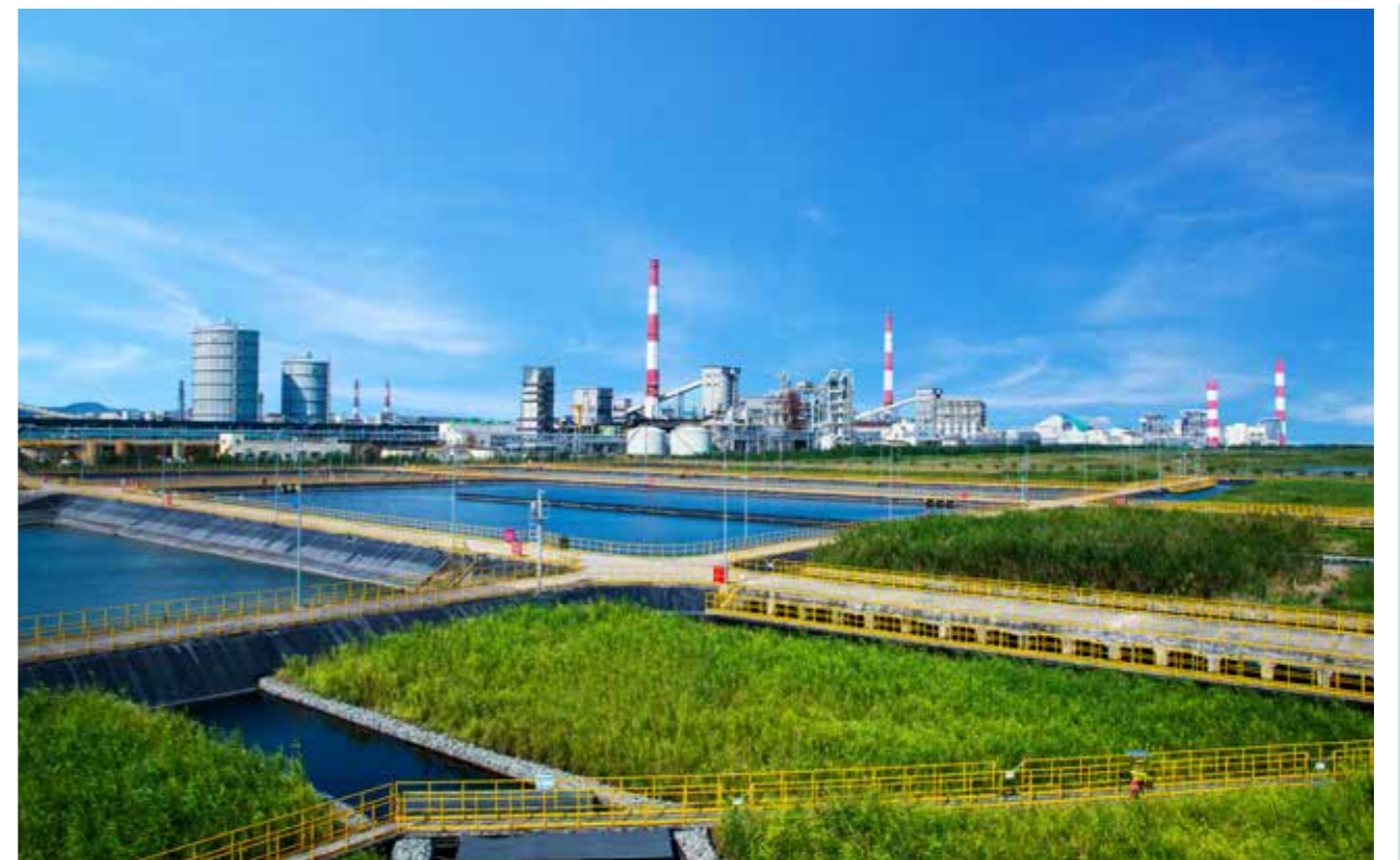
..... 台塑河靜鋼鐵公司
