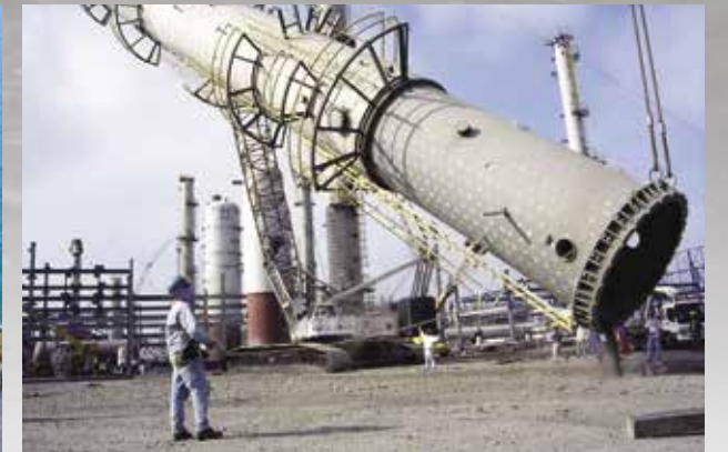
厂房与塔槽安装
