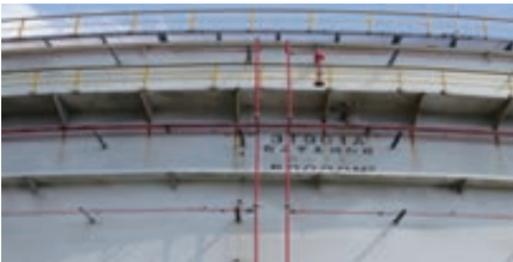
環路末端設置排水管線
