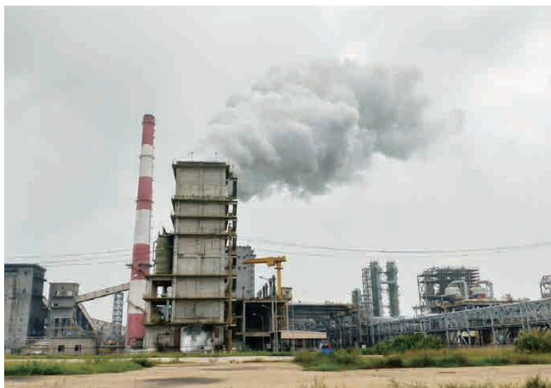
以濕熄塔進行熄焦作業產生大量水蒸氣逸散
