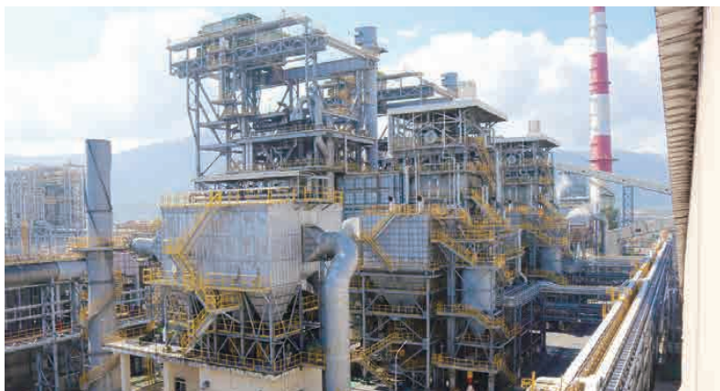
二套乾熄焦系統進行熄焦作業無產生大量水蒸氣逸散
