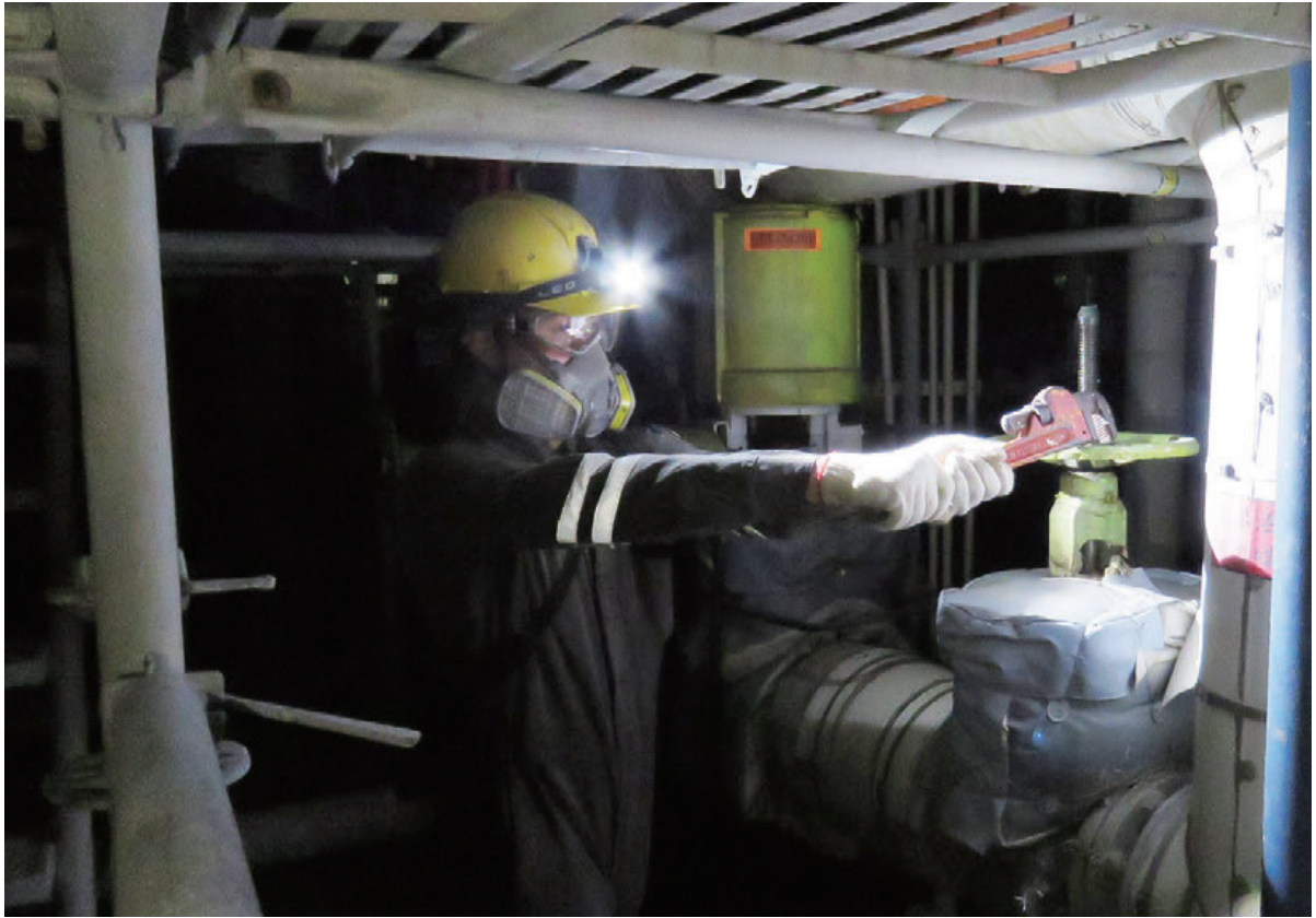
夜間全黑製程安全停車設備閥件遮斷
