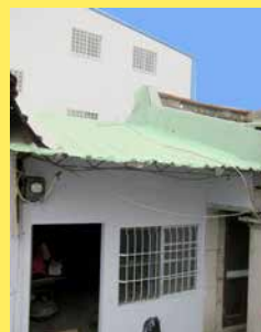
屋頂漏水-改善後
