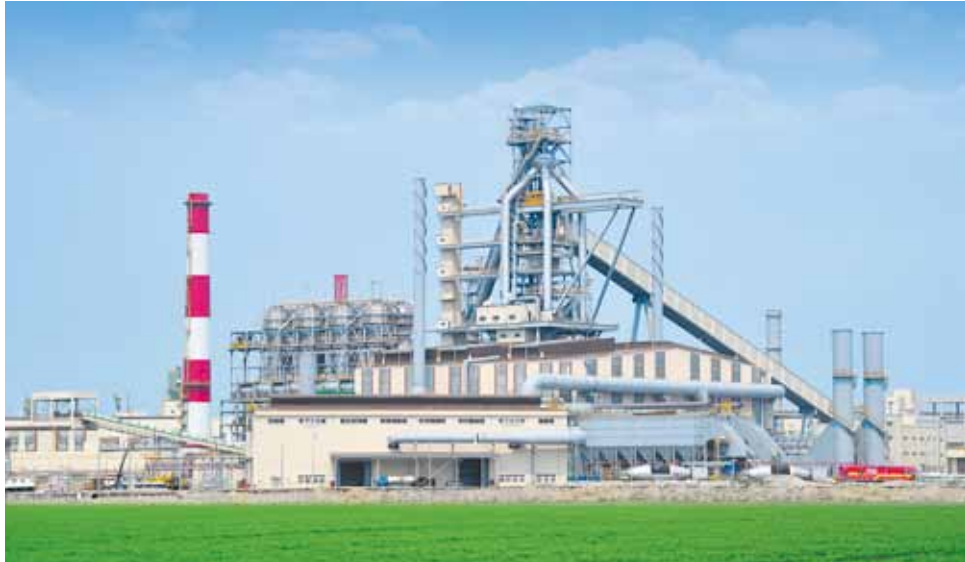
台塑河靜鋼鐵公司 1 號高爐
