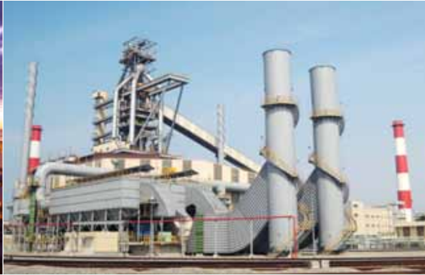
台塑河靜鋼鐵公司 1號高爐
