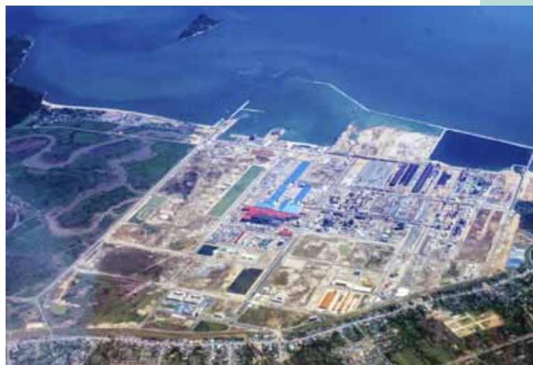
台塑河靜鋼鐵公司
