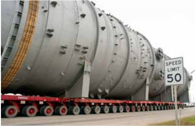
德州擴建案大型製程設備運送途中
