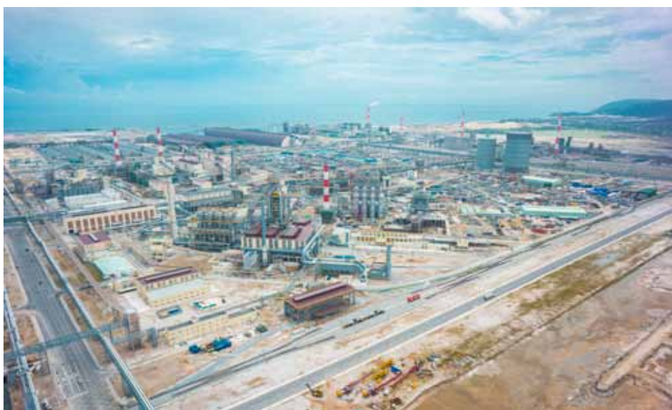
日夜趕工中的台塑河靜鋼鐵公司大煉鋼廠
