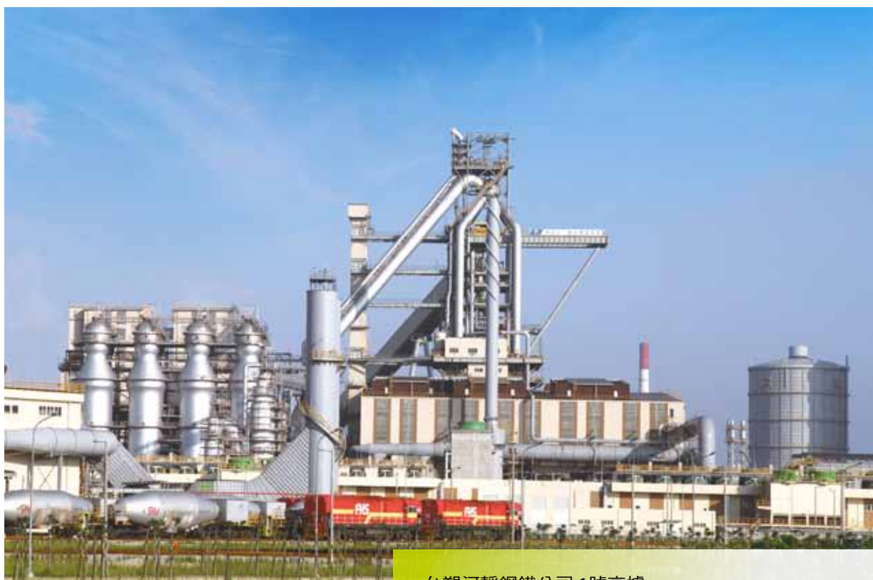
台塑河靜鋼鐵公司 1號高爐
