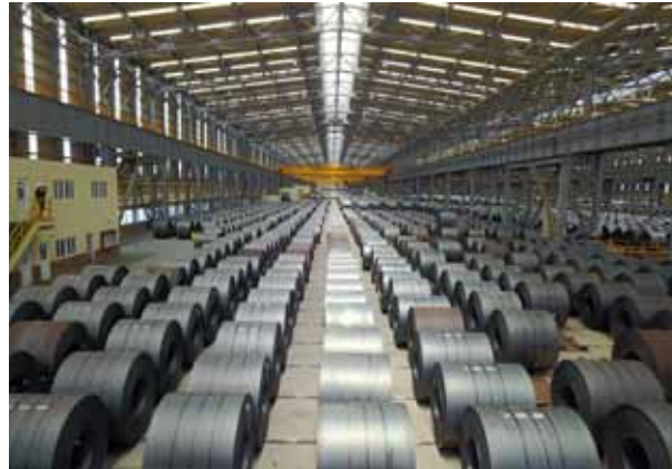
台塑河靜鋼鐵公司 熱軋鋼廠
