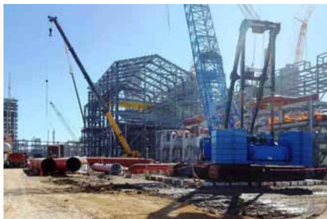
美國德州廠區第四期新廠擴建 配管安裝工程
