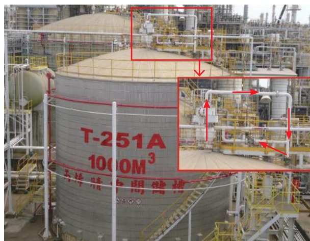
儲槽排氣密閉收集至燃燒處理設備
